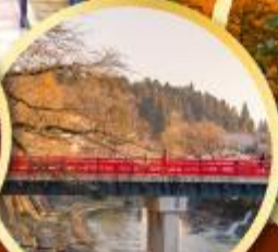
สะพานนากะบาชิ
